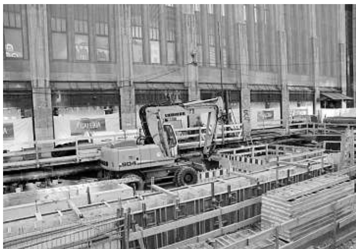
Baustelle neben dem Kaufhof an der Kö. Fotos (2): M. Neuhardt
