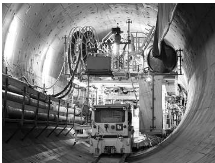
Tuborine wird die gewaltige Bohrmaschine genannt, die den größten Teil des Tunnels für die Wehrhahnlinie im unterirdischen Schildvortrieb errichtet. Foto: Stadt Düsseldorf
